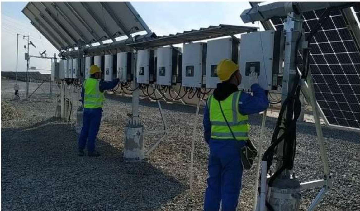
ຮູບທີ 4: ອິນເວີເຕີ ຫຼື ເຄື່ອງແປງກະແສໄຟຟ້າກຶງເປັນກະແສສະລັບ
